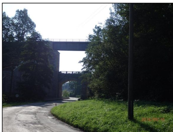
Železniční most v Bernarticích
